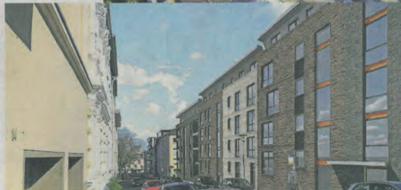
So stellt sich der Investor Rheinquadrat das Croonsquartier von der Yorckstraße aus gesehen vor.
